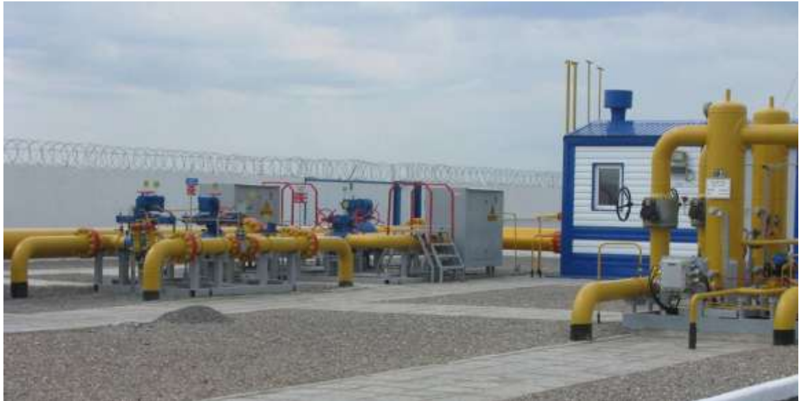
Рисунок 3 – Бочная сепарационная установка на ГРС Нижняя Шапша ООО «Газпром трансгаз Уфа»
