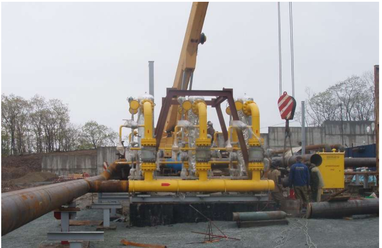
Рисунок 6 – Монтаж БСУ на объекте
